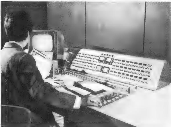
Bild 3. Zentrales Ansaagestudio mit Beobachtungsgerät für die optische Nachrichtenübermittlung im Flughafen. Vorn rechts die „Prioritätsschalter“ zum Aufschalten aller zeitweilig abgetrennten Teile der Lautsprecheranlage auf diese Zentrale (Foto: Jean Mainbourg, Paris)
